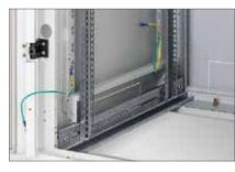
■ Pospojení Všechny oddělitelné části jsou vzájemně pospojeny dle požadavků příslušné normy.
